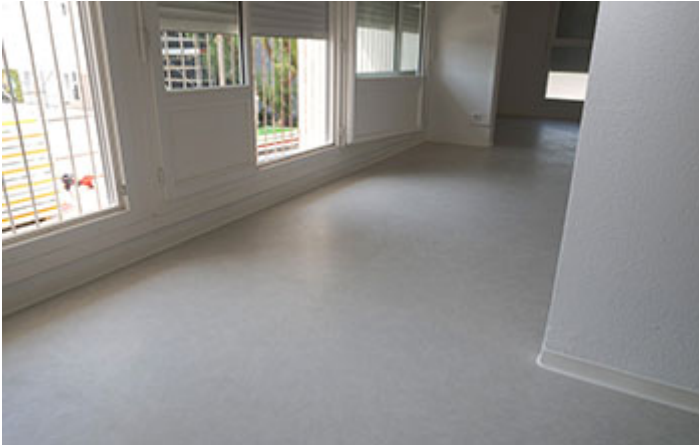
L'opération de réhabilitation des 3 000
