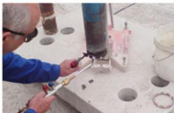
2 - Après le nettoyage du tube, mise en place du nouvel anneau, chauffage et brasage
