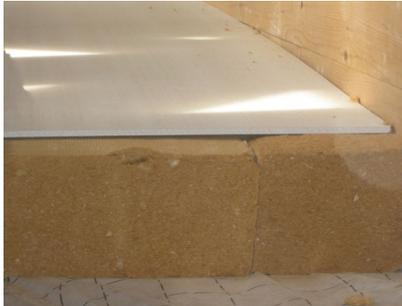
Le panneau souple isolant en fibres de bois holzFlex développé par
