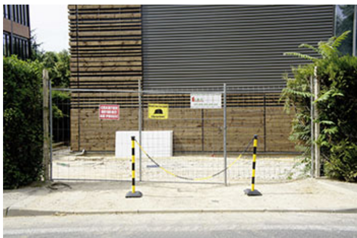
Entretien des espaces verts, travaux sur la
