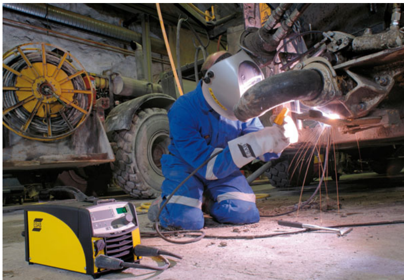
En matière de soudage à l'arc
